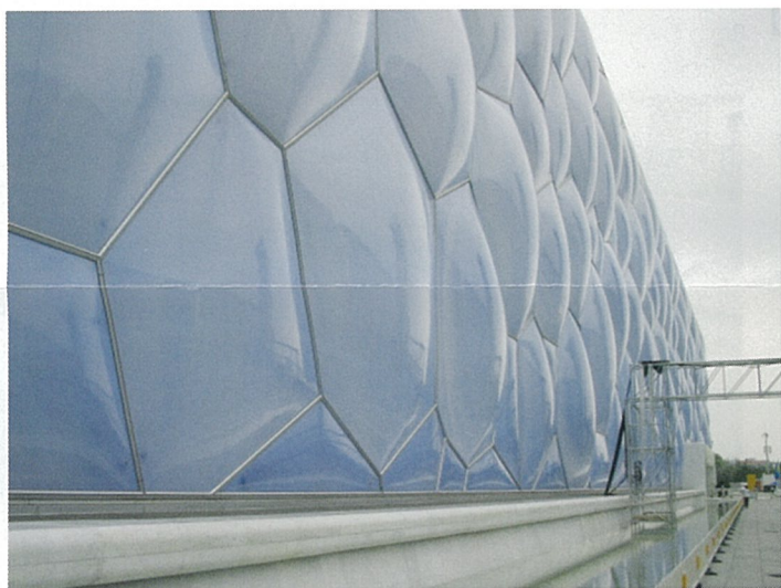
【写真4】▲北京国家水泳センター「ウォーターキューブ」の壁面ETFE膜(熱可塑性フッ素樹脂)
