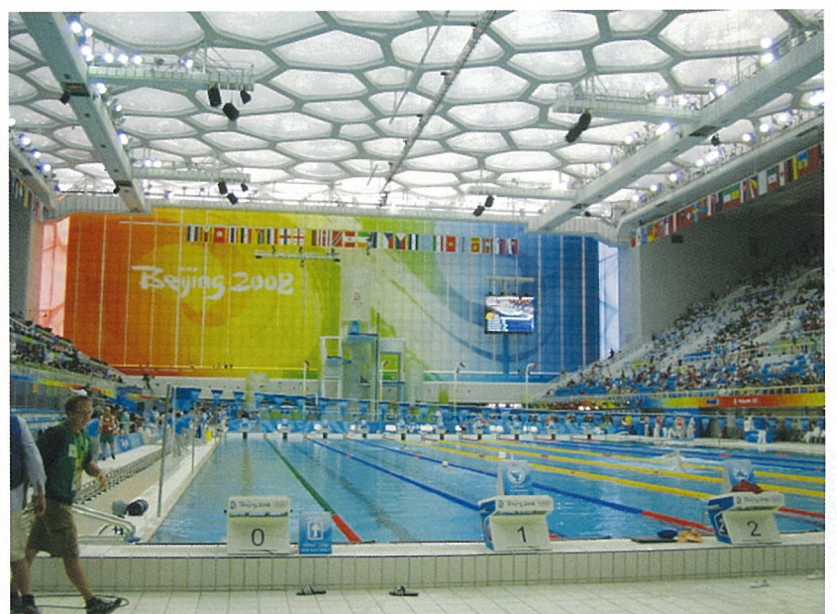
【写真9】▲自然光採光方式メインプール
